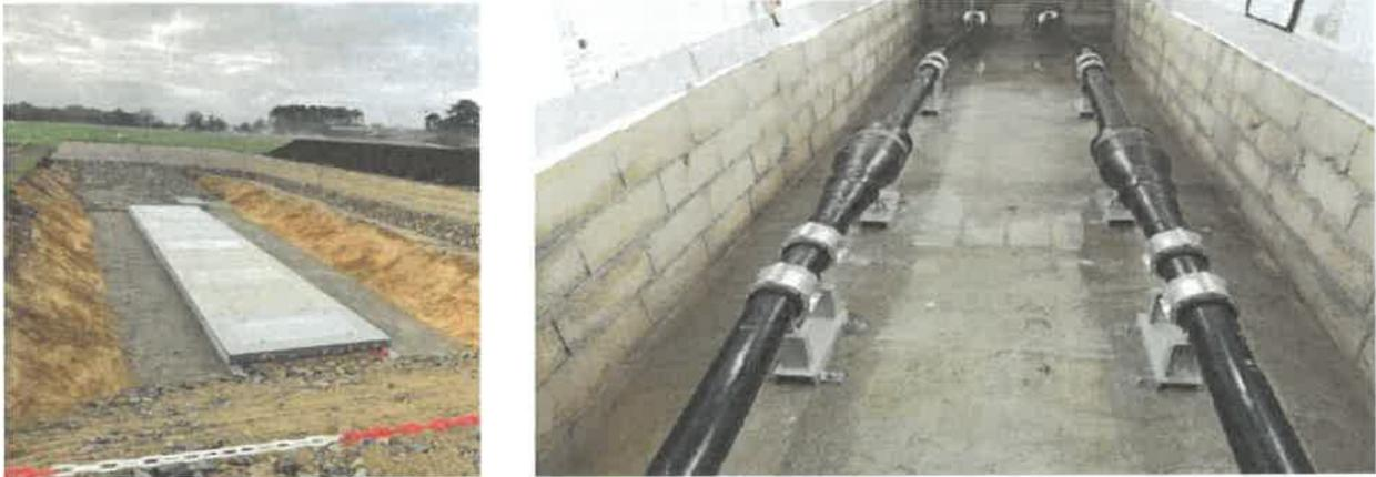
Figure 4: Exemple de chambre de jonction sous voirie (source: RTE)
